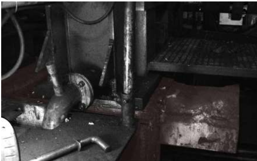
Rys2. Fundament pod reduktorem zespołu tnącego.
