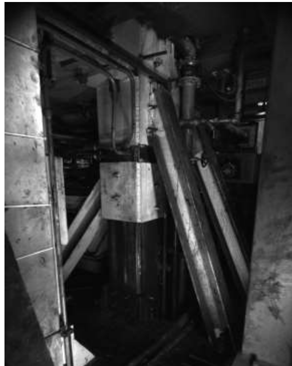
Rys6. Konstrukcja stalowa wspierająca filary.
