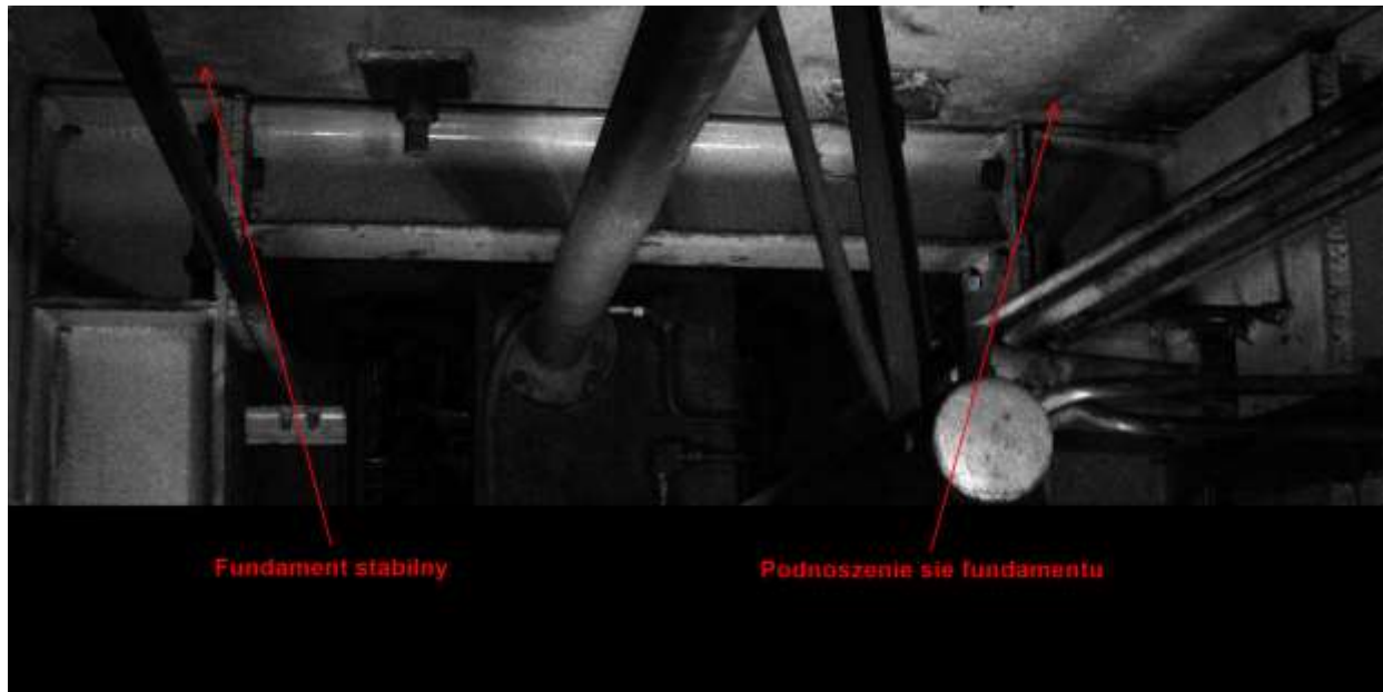
Rys5. Konstrukcja wspierająca fundament.
